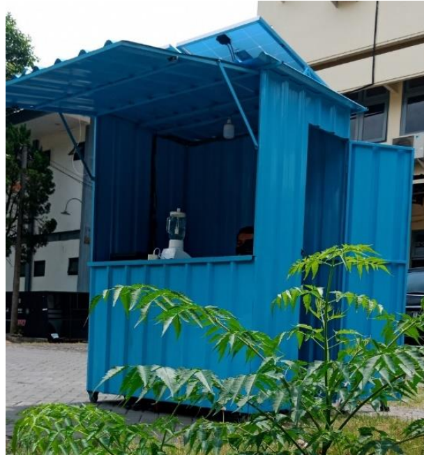
Gambar 2. Kios yang telah terbangun
